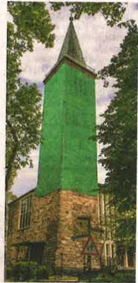
Ein Netz umspannt den Turm der Pauluskirche. FOTO: INGO OTTO / FFS
