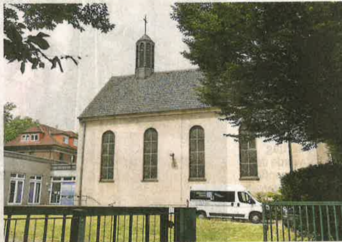
Die evangelische Gnadenkirche in Schalke-Nord soll abgerissen werden. Im benachbarten früheren Gemeindehaus ist die Diakoniestation samt Tagespflege untergebracht worden. FOTOS: IOACHIM KLEINE-BÜNING / FUNKIE FOTO SERVICES
